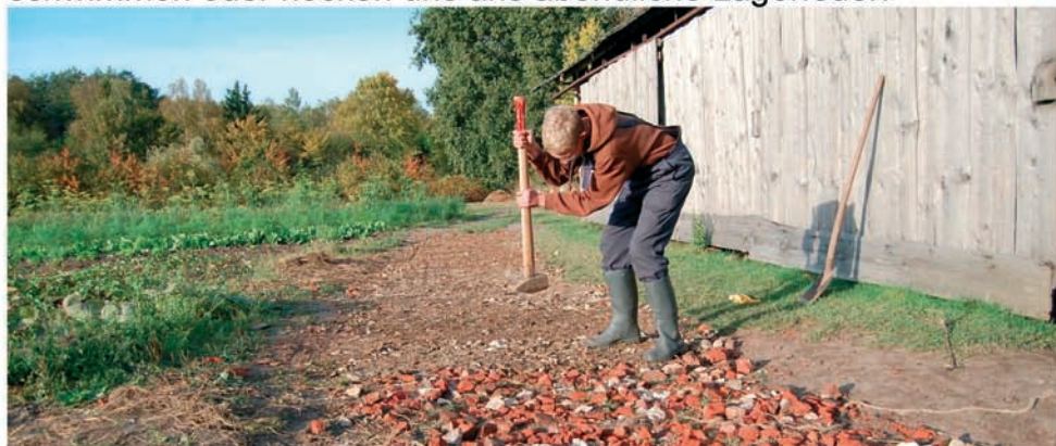
Wegebau mit einfachen Mitteln
