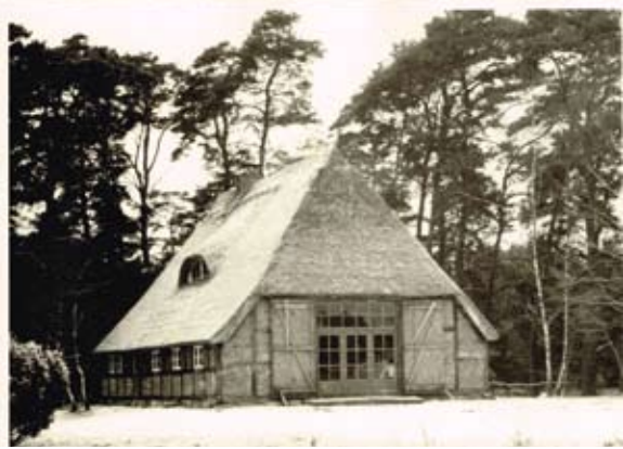
Der Schafstall fertig am 1. Dezember 1951.
